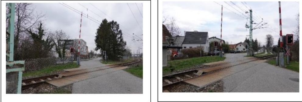
Abbildung 16: Blick von der L 159 zum Bahnhofsbereich
