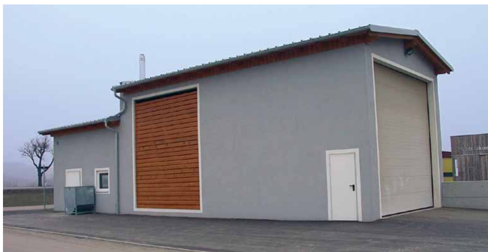
Biomasse-Nahwärmanlage Groß Sierning
